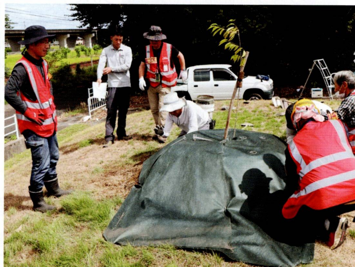
乾燥防止のため防草マットを施工
